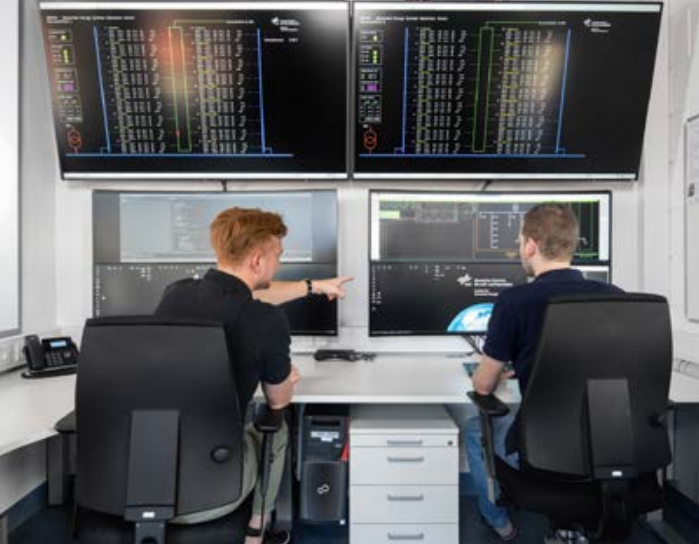
Im Emulationszentrum NESTEC des DLR-Instituts für Vernetzte Energiesysteme lassen sich komplexe Stromnetze realitätsnah nachbilden.
