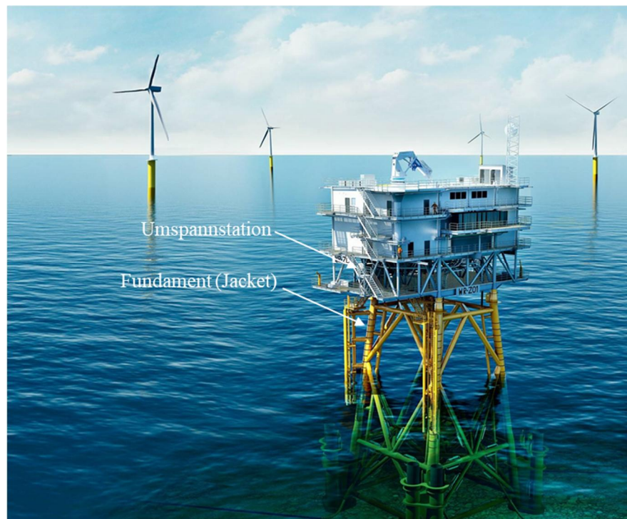
Abb. 5.7: Umspannplattform ©Ramboll (Bendlin et al. 2021, S. 83)
