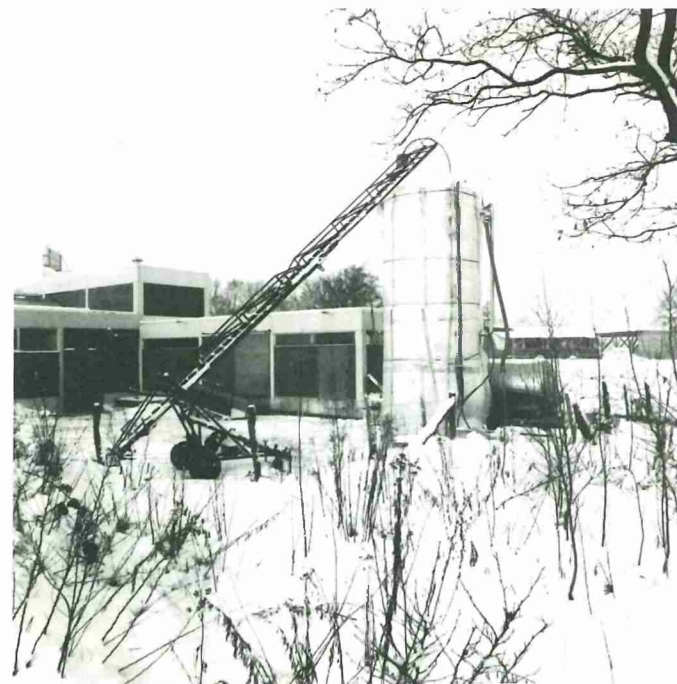
Im Bau befindliche Biogasanlage (Technikumsstadium)
