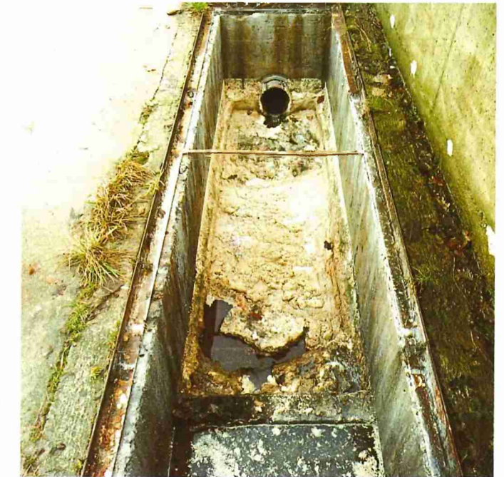
Abwasserkanal eines Schlachthofes
