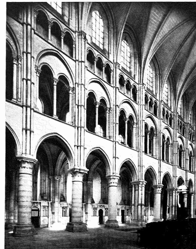
Laon Kathedrale, nördliche Mittelschiffwand des Langhauses. Der Bau wurde seit etwa 1160 errichtet.
