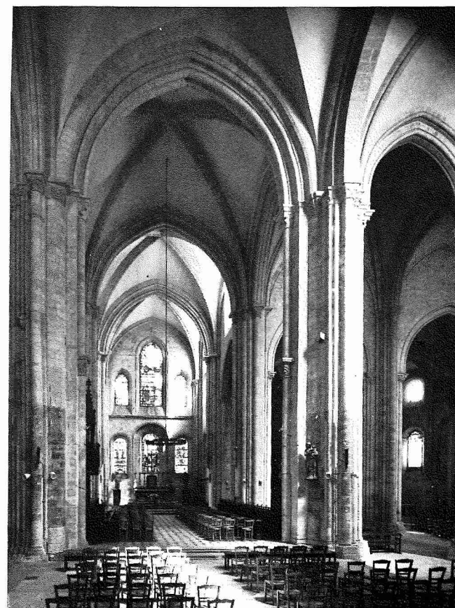
Etampes Stiftskirche Notre-Dame-du-Fort, Blick nach Osten. Die Formen orientieren sich an Bauten, die dem Königshaus nahestehen.
