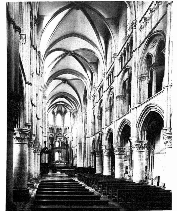
Mouzon Benediktinerabteikirche Notre-Dame, Blick ins Mittelschiff nach Osten. Obwohl erst nach 1212 errichtet, zitiert man hier die veralteten Formen der Kathedrale von Laon.
